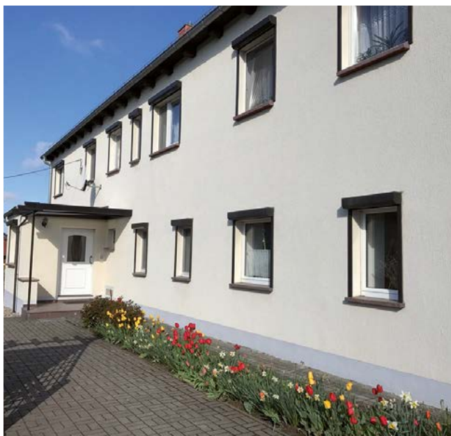
Dieses Haus sieht jetzt nicht nur hübsch aus, sondern ist auch noch trocken!
